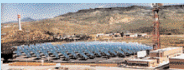
Figura 4. Eurelios, la prima centrale solare al mondo a concentrazione (1 MW di potenza) con ricevitore centrale a torre, costruita nel 1980 ad Adrano, Catania (foto Musil, Brescia).
