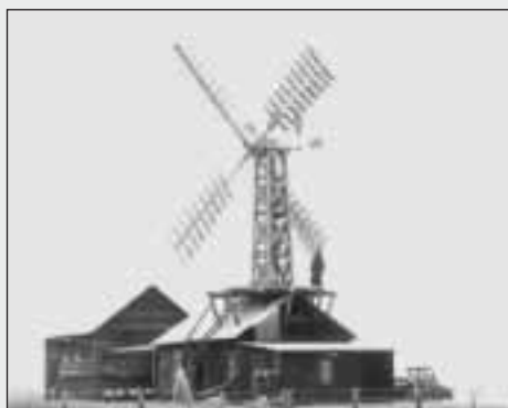
Figura 3 Centrale di Askov in Danimarca Fonte: Eric Hau, Wind Turbines , Springer, Berlin 2009
